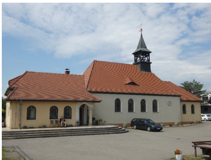
Fot. 16. Kościół w Radwanicach
