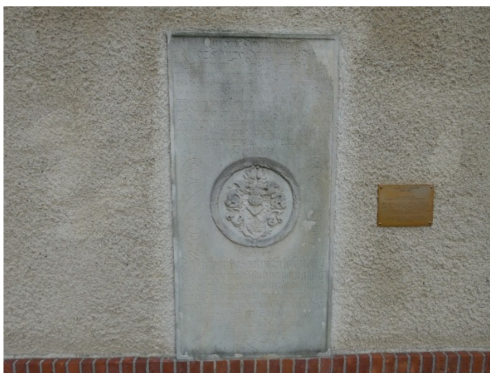
Fot. 20. Epitafium na elewacji kościoła w Trestnie
