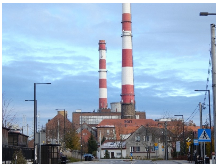
Fot. 11. Elektrociepłownia „Czechnice” w Siechnicach
