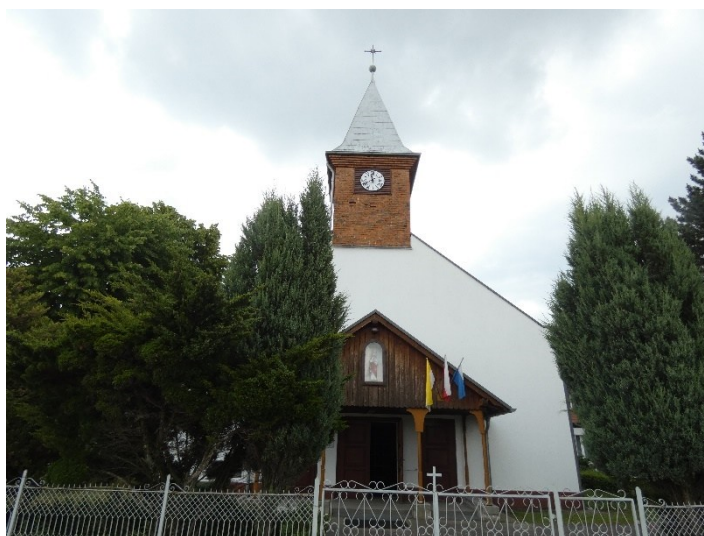
Fot. 15. Kościół w Kotowicach
