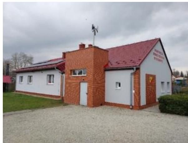
Fot. Termomodernizacja budynku OSP w Sulimowie
