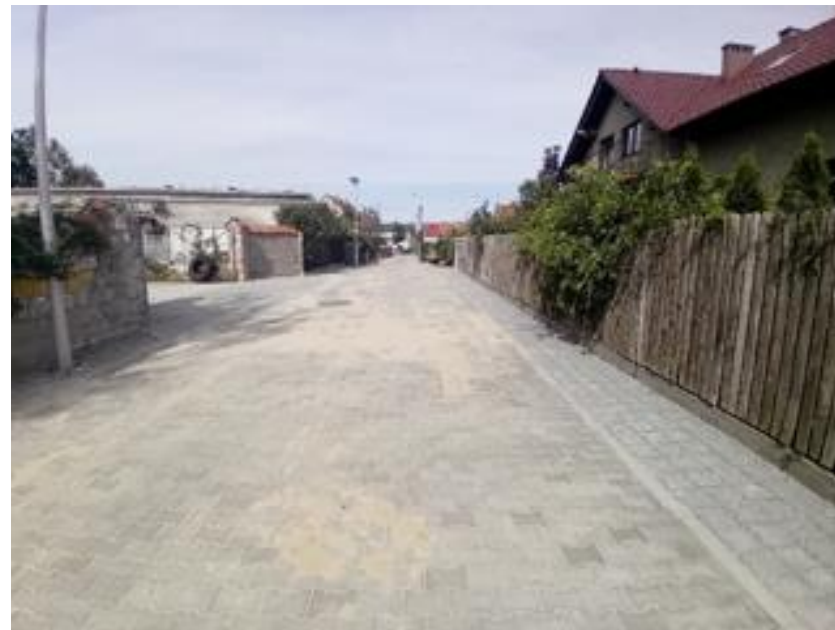
Fot. Przebudowa sięgacza ul. Kościuszki w Iwinach
