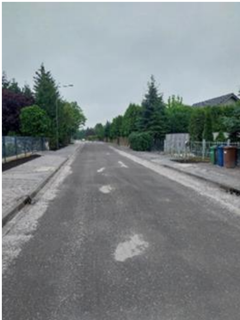
Fot. Przebudowa ul. Brzozowej i Letniej w Żernikach Wrocławskich
