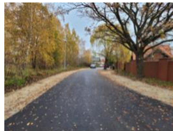
Fot. Remont ul. Lazurowej i Tęczowej w Radwanicach
