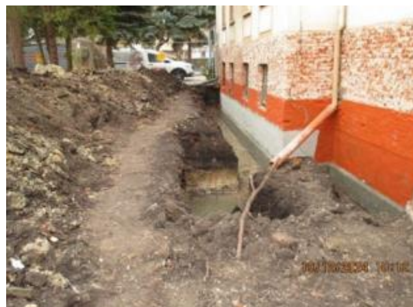
Fot. Modernizacja budynku przedszkola w Żernikach Wrocławskich
