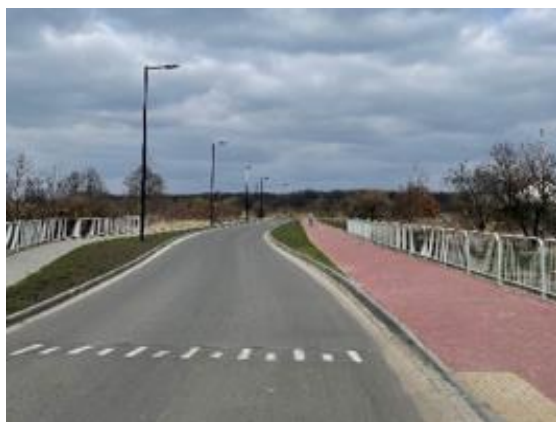
Fot. Budowa łącznika ul. Henryka III z ul. Paderewskiego w Siechnicach
