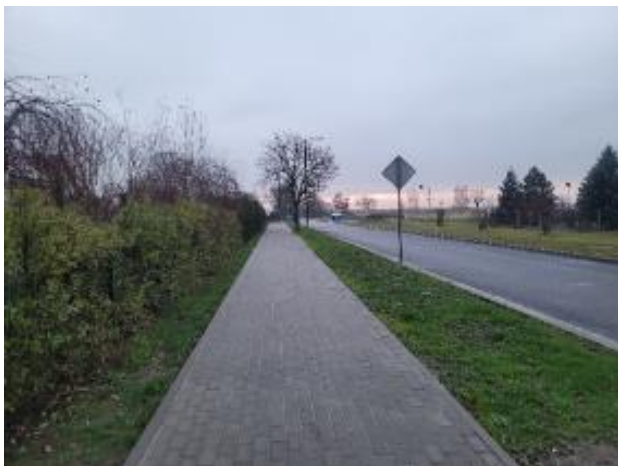
Fot. Budowa chodnika na ul. Henryka III w Siechnicach
