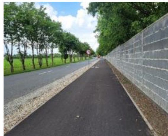
Fot. Przebudowa drogi powiatowej w Smardzowie
