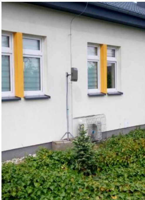
Rysunek 13. Czujnik pomiaru jakości powietrza przy Żłobku Samorządowym, ul. Mickiewicza.
