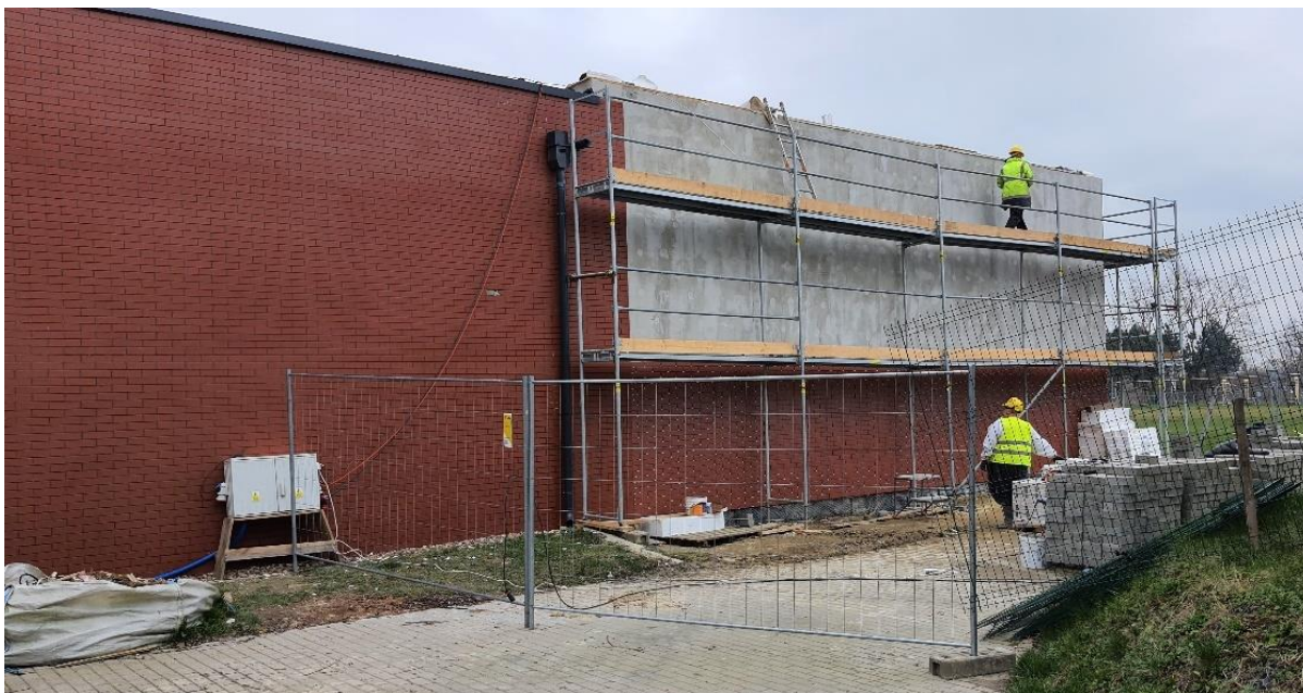
Rozbudowa istniejącego budynku SUW w Groblicach o nową halę filtrów
