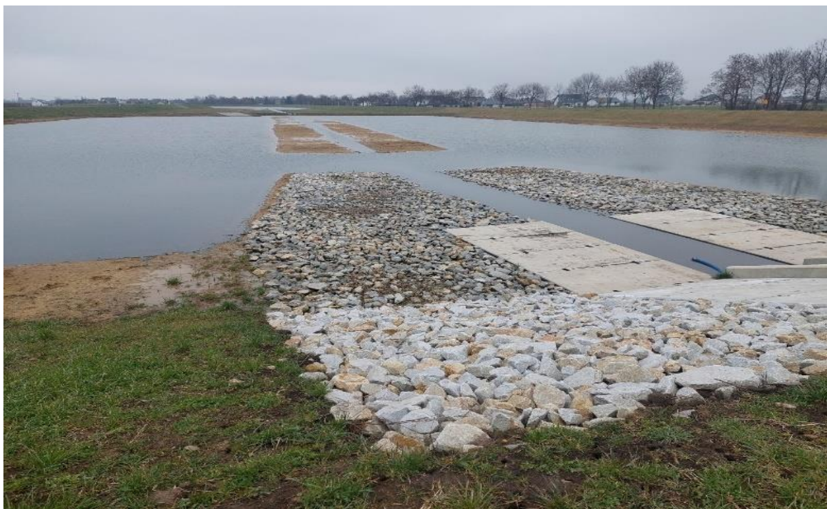
Część filtracyjna zbiornika wielofunkcyjnego w Smardzowie
