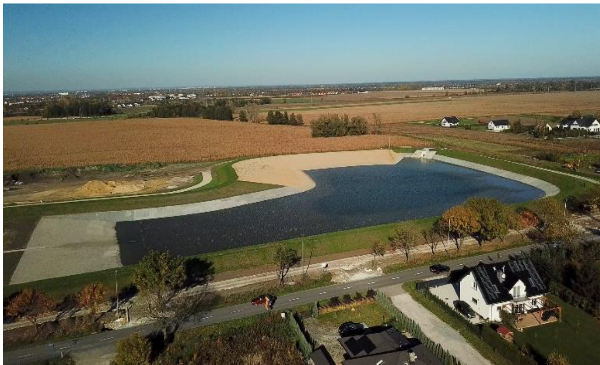
Część retencyjna zbiornika wielofunkcyjnego w Smardzowie
