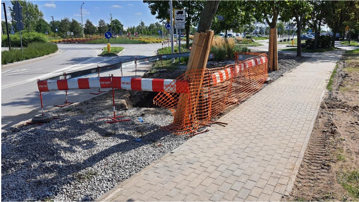
Budowa kanału tłoczego PE-HD 250 mm od pompowni ścieków „Bio-blok”
