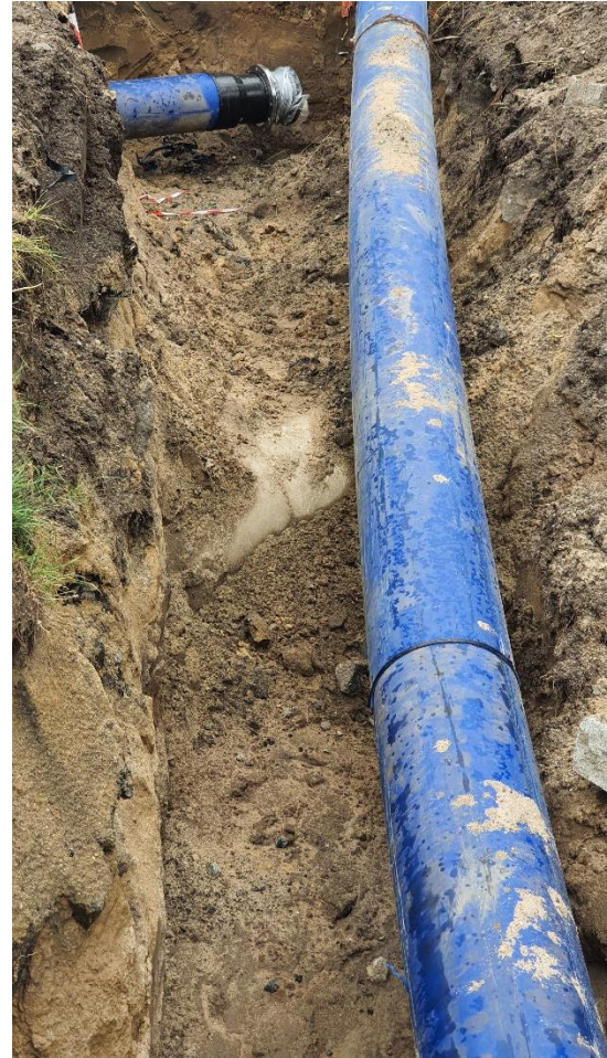
Budowa wodociągu przesyłowego od stacji SUW w Groblicach do ul. Zielonej w Siechnicach
