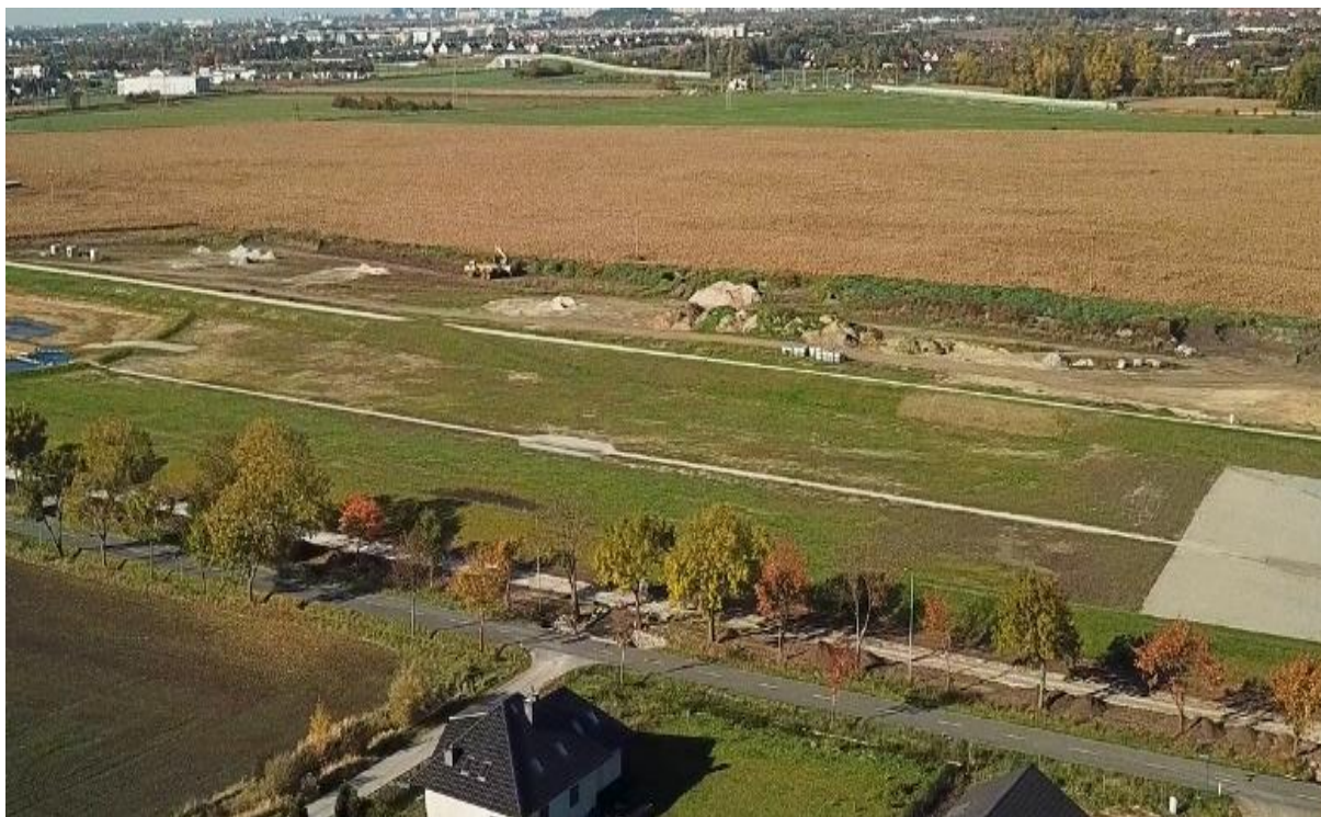
Część powodziowa zbiornika wielofunkcyjnego w Smardzowie
