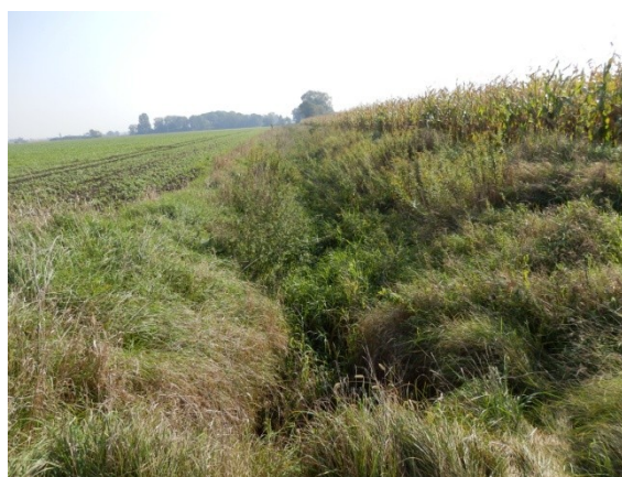
Fot. 18. Rów do konserwacji lub odbudowy w Sulęcinnie-Szostakowicach
