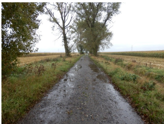
Fot. 23. Droga w Świętej Katarzynie, po której poprowadzony będzie szlak rowerowy
