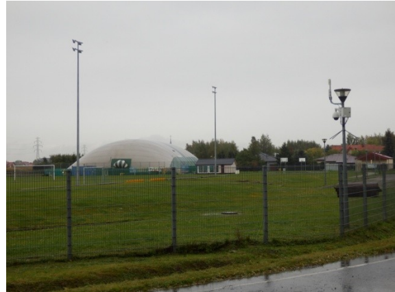
Fot. 12. Kompleks sportowy w Radomierzycach
