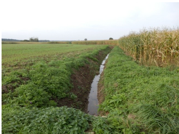
Fot. 5. Rów melioracyjny w obrębie Kotowice
