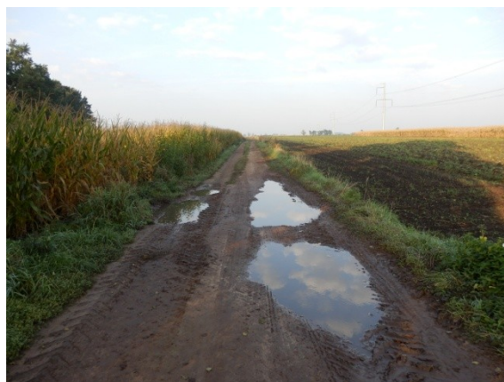
Fot. 20. Droga w Sulimowie wskazana do przebudowy (dz. 20/2)
