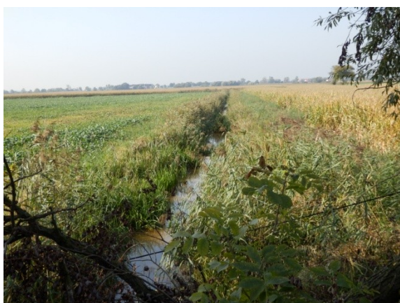
Fot. 17. Rów do konserwacji lub odbudowy w Groblicach
