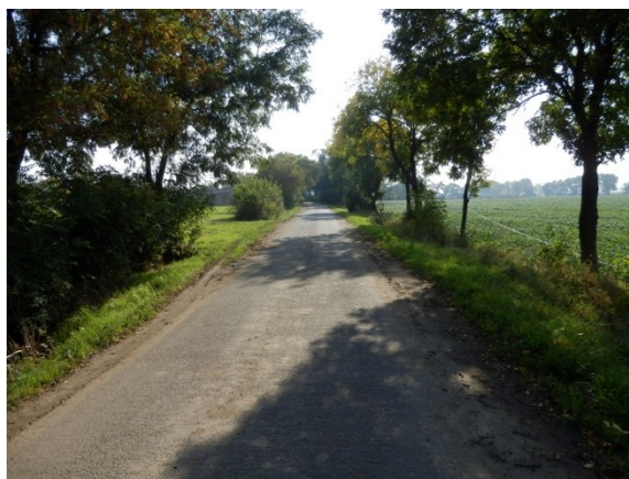
Fot. 2. Droga asfaltowa w Groblichach
