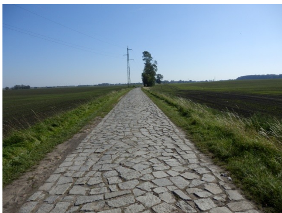
Fot. 1. Droga brukowa w Łukaszowicach
