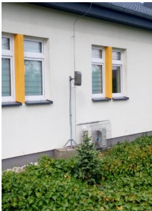
Rysunek 59. Czujnik pomiaru jakości powietrza przy Żłobku Samorządowym, ul. Mickiewicza.
