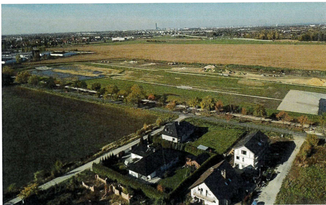
Część powodziowa zbiornika wielofunkcyjnego w Smardzowie
