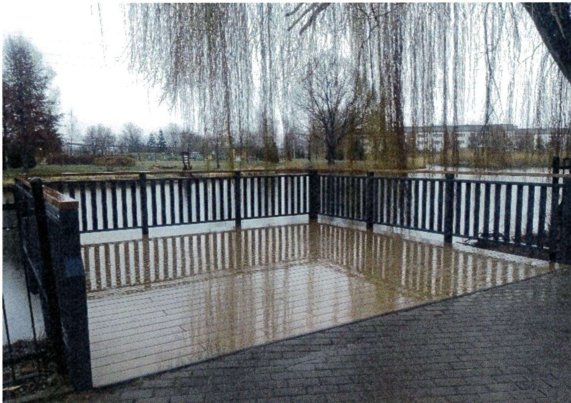
Wyremontowany taras widokowy na stawie parkowym w Siechnicach
