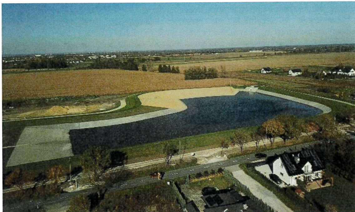
Część retencyjna zbiornika wielofunkcyjnego w Smardzowie
