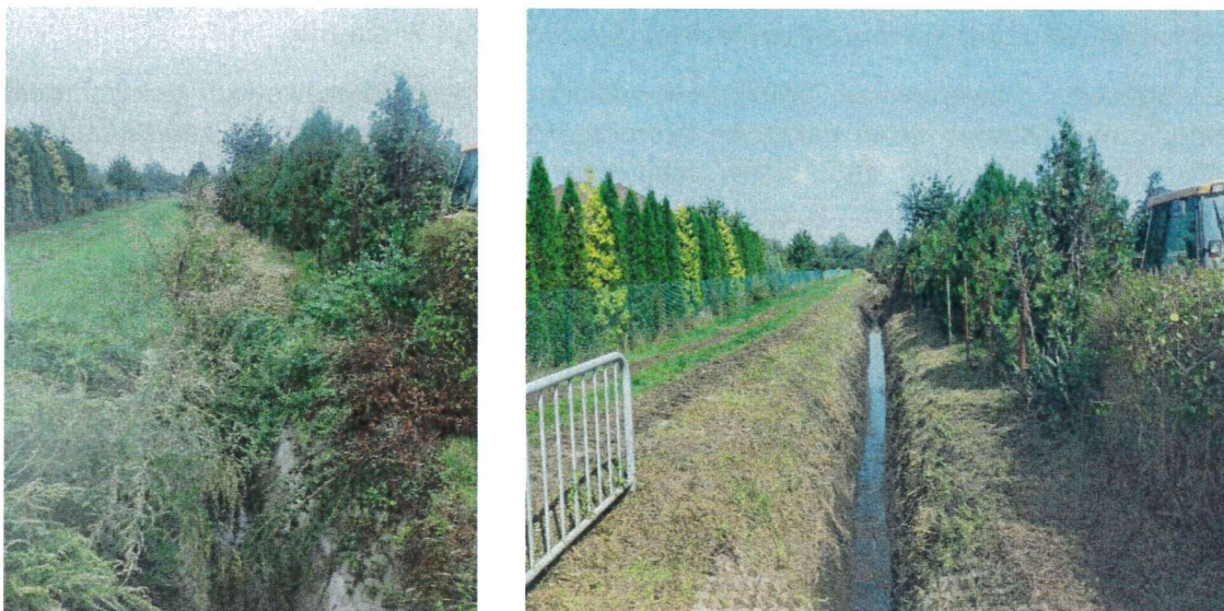
Rów melioracyjny w Zacharzycach - przed i po konserwacji
