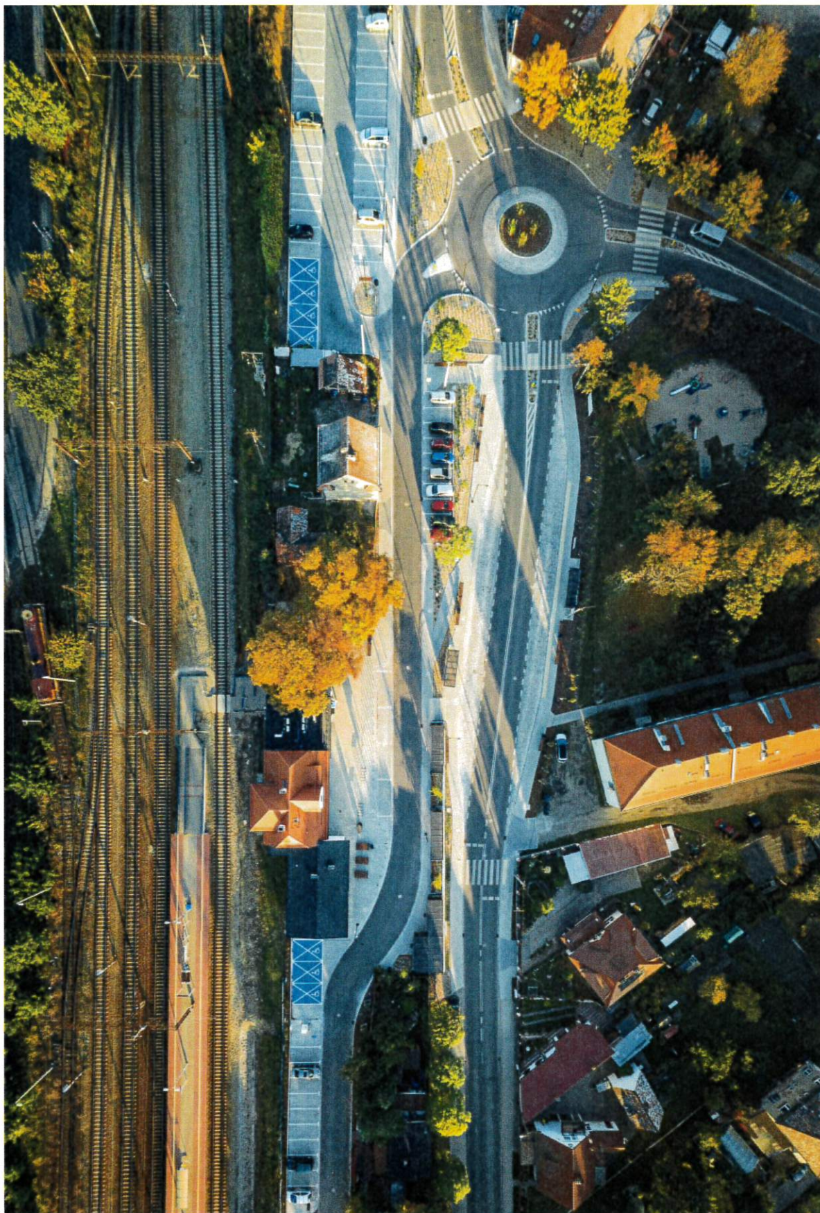
Zdjęcie nr 3 – rondo u zbiegu ulic Kolejowej i Szkolnej w Siechnicach
