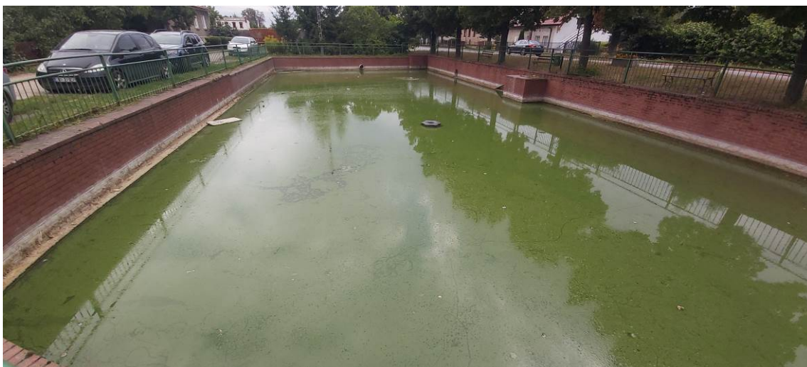
Rycina 14. Stały zanieczyszczony zbiornik w Żernikach Wrocławskich.
